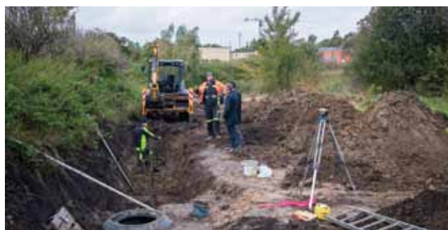
Wykonawcą prac wyłonionym w drodze przetargu jest Zakład Usług Komunalnych sp. z o.o. w Suszu. Wartość inwestycji opiewa na kwotę 1.125 000,00 zł.
