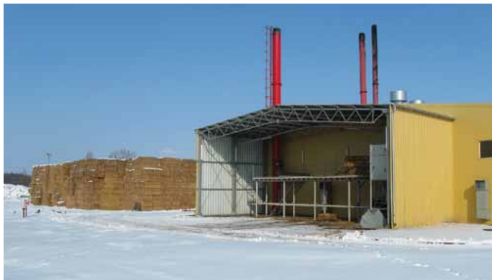
Spalarnia słomy. Daje ciepło prawie całemu miastu Kisielice i radykalnie zmniejsza emisję gazów cieplarnianych
